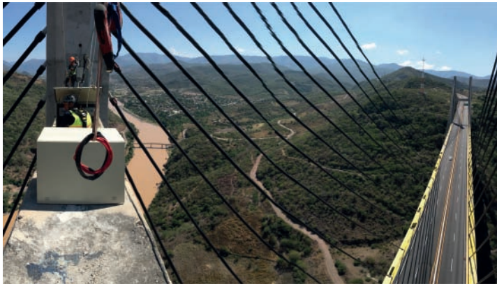
Monitoreo remoto del Puente Mezcala.
