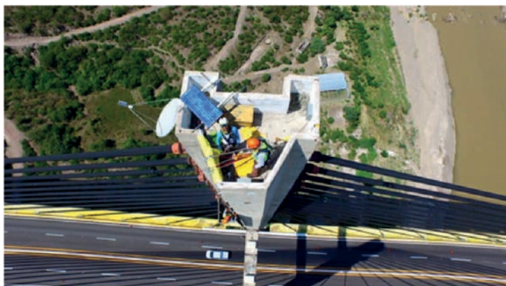
Figura 3. Antena satelital puente Mezcala.
