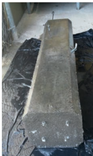
Figura 2b: Proceso de curado de concreto
