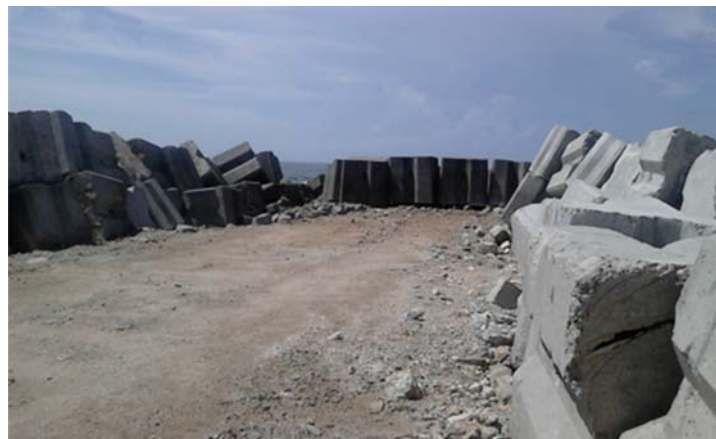
Imagen 1. Vista del morro de la escollera Este en la boca de la laguna La Pastoría
