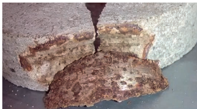
Imagen 2. Avanzado estado de corrosión de varillas en pilote 2N y 50S respectivamente.
