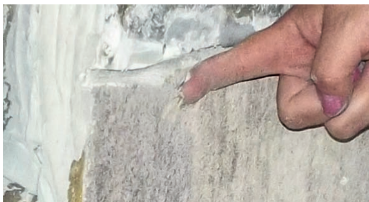
Imagen 1. Desprendimiento del mortero epóxico.
